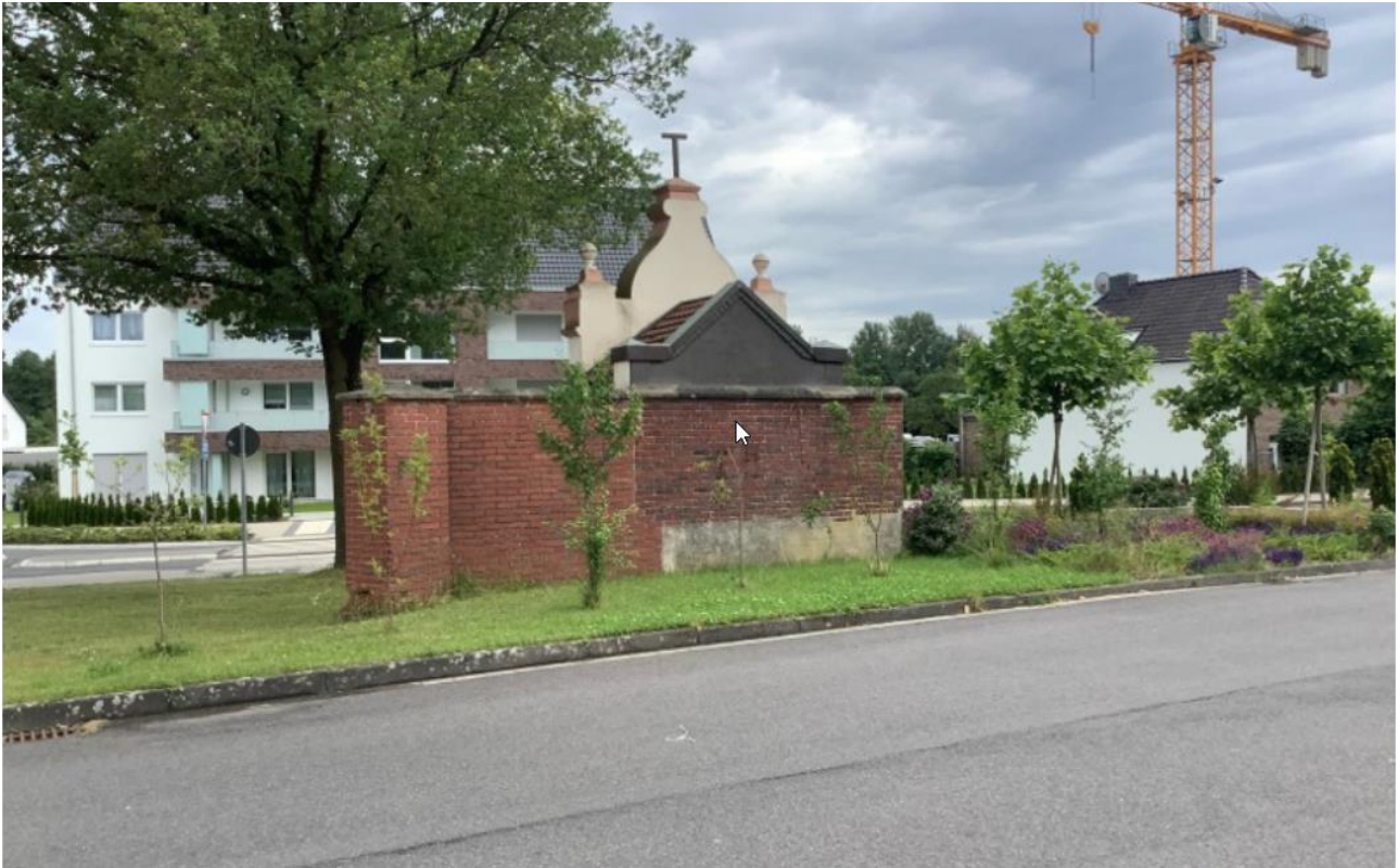
Beispiel 1: Die Rückseite der Hagelkreuzkapelle ist das allerletzte erhaltene Stück der einst zahlreichen Ziegelgebäude, die sich entlang der Borner Straße aneinanderreihen.
